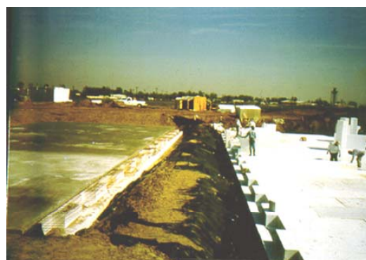
Рис. 6. Устройство подъезда для такси в международном аэропорту г. Новый Орлеан
