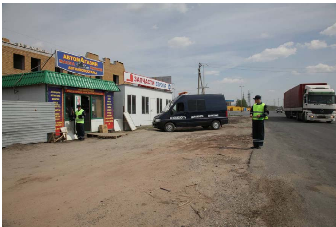
Объект размещенный с нарушением требований по безопасности дорожного движения
